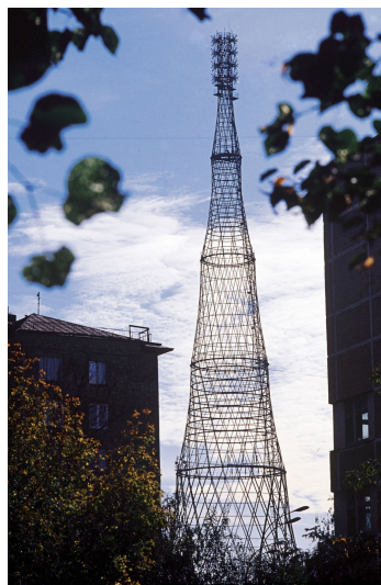
Figure 13: La tour Choukhov à Moscou dont chaque portion est un morceau d'hyperboloïde.
